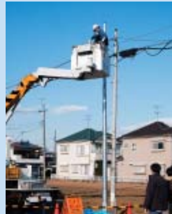
エコ鋼管柱の設置
