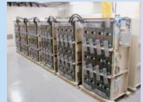
蓄電池による電力貯蔵システム
