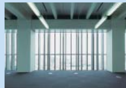
遮熱性の高い素材を採用した、縦型の可動ルーバー
