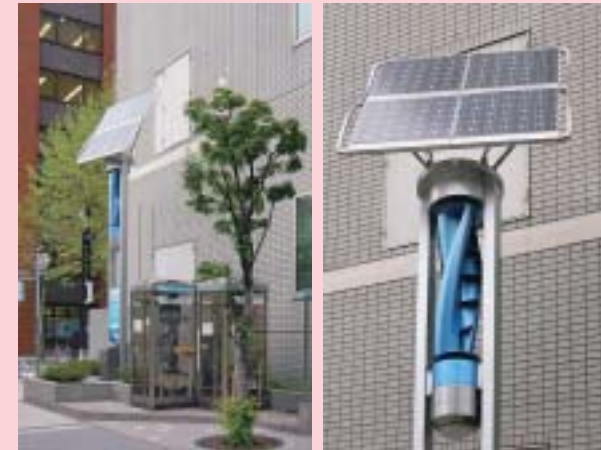
太陽光・風力ハイブリッド電源装置。ソーラーパネル部分は、積雪の影響を最小限にとどめる角度に調整。また、風車部は静音性が特長。自然の力でつくられる発電量が現在どれくらいなのか、通行人にもすぐわかるよう、掲示板を設置
