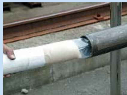
腐食などにより老朽化・脆弱化した管路に、樹脂付きホースを敷設して膨ませ、固めて補強
