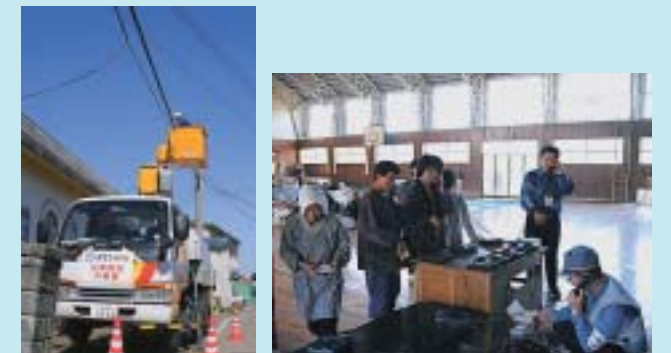
災害後の通信ケーブルの応急復旧作業
